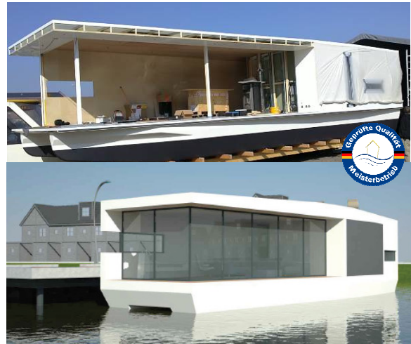
Hausboot NOMAD - Fertigstellung Oktober 2010
